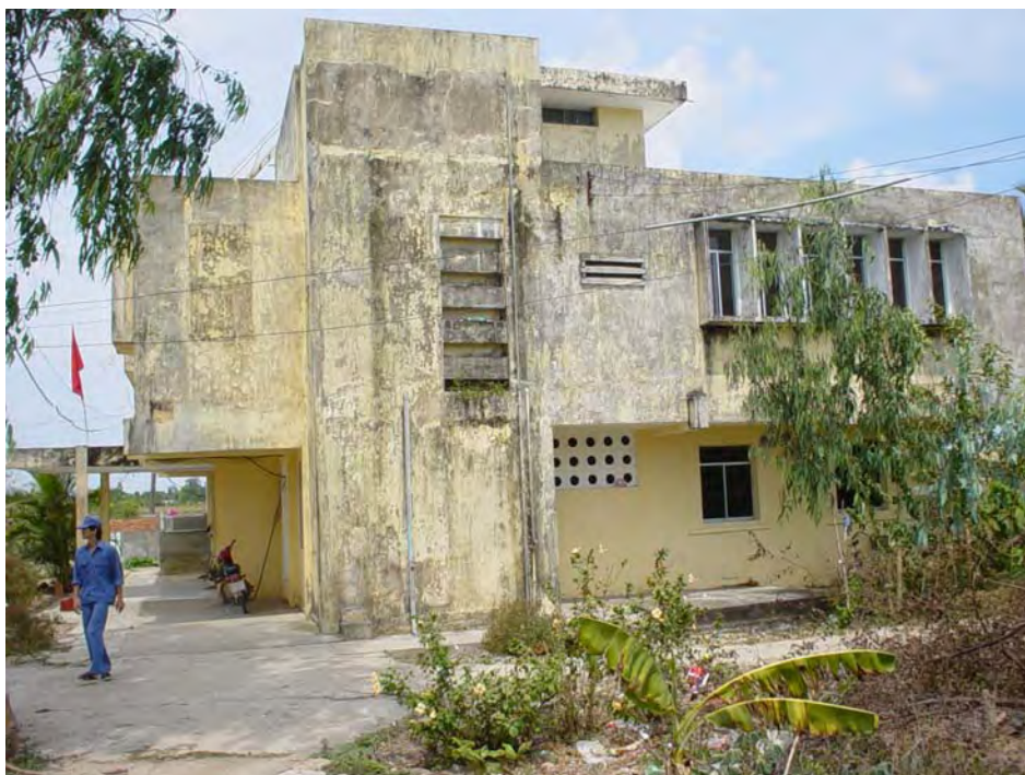
Fig. 2. Main building of the Bac Lieu Observatory
